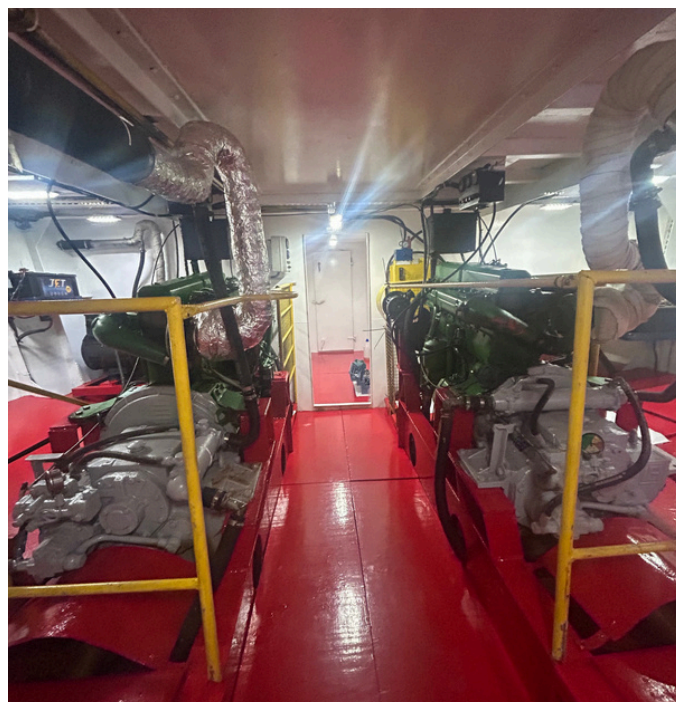
PRAÇA DE MÁQUINAS
